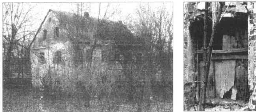
Stare mury murowanej części budynku „młyna” w Goli Budynek zarośnięte krzakami i drzewami, okna zabezpieczone przed wejściem do budynku. Ta ruina to plama Goli – stan z 2014 roku.
